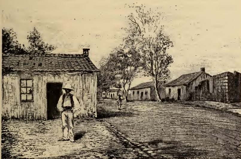
Fig. 31. — La maison du colon, telle qu'on la rencontre trop souvent: bloc rectangulaire de deux ou trois pièces, sur lequel tout le jour le soleil darde ses rayons, ouvre sa porte et ses trop grandes fenêtres sur le bord de la route, qui apporte la poussière et les vagabonds.
